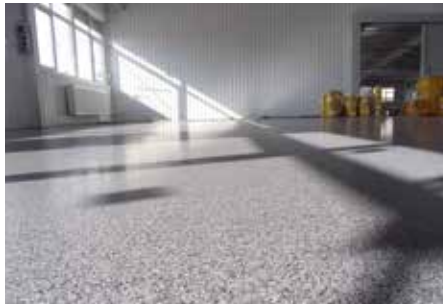
Uppströad färgsandsbeläggning: 2-3 mm
